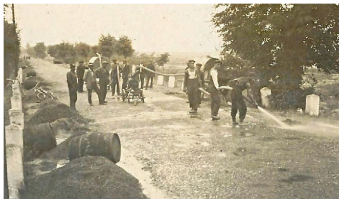
Oprava a položení asfaltového povrchu naší (do té doby prašné) hlavní silnice v roce 1928.
