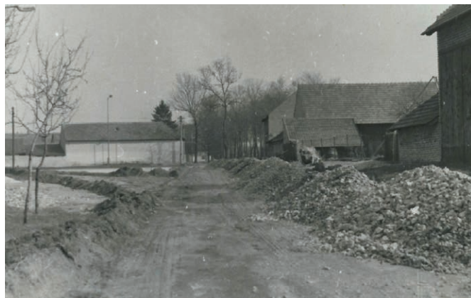
Oprava a položení asfaltového povrchu naší (do té doby prašné) hlavní silnice v roce 1928.
