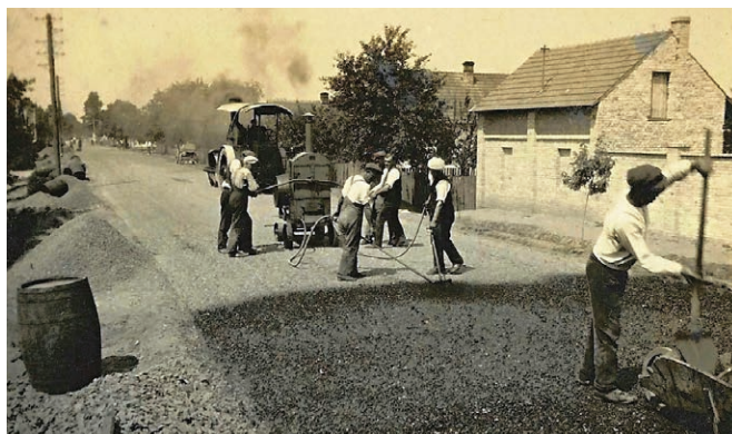
Oprava a položení asfaltového povrchu naší (do té doby prašné) hlavní silnice v roce 1928.
