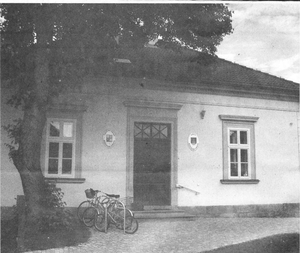
Bývalá fara, dnes nedávno opravená budova obecního úřadu. Foto: Deník/Milena Jínová
